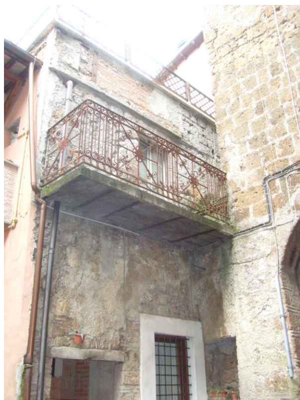
Esterno – Fronte principale
